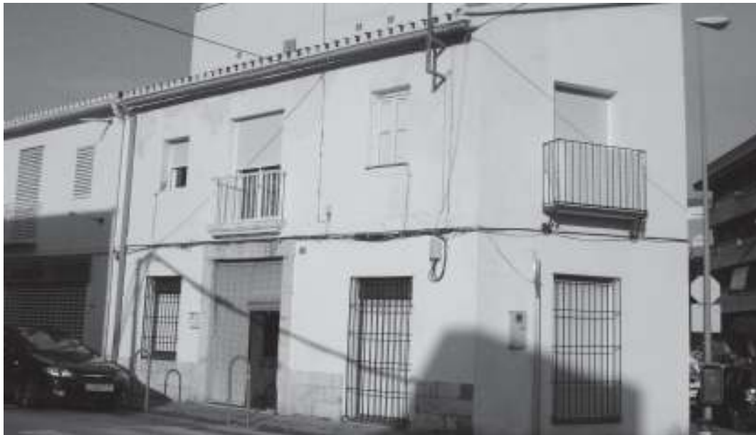
Casa del fielato que es conserva a l'encreuament de l'avinguda de València i el camí de Gandia. Arxiu Municipal de Dénia.
